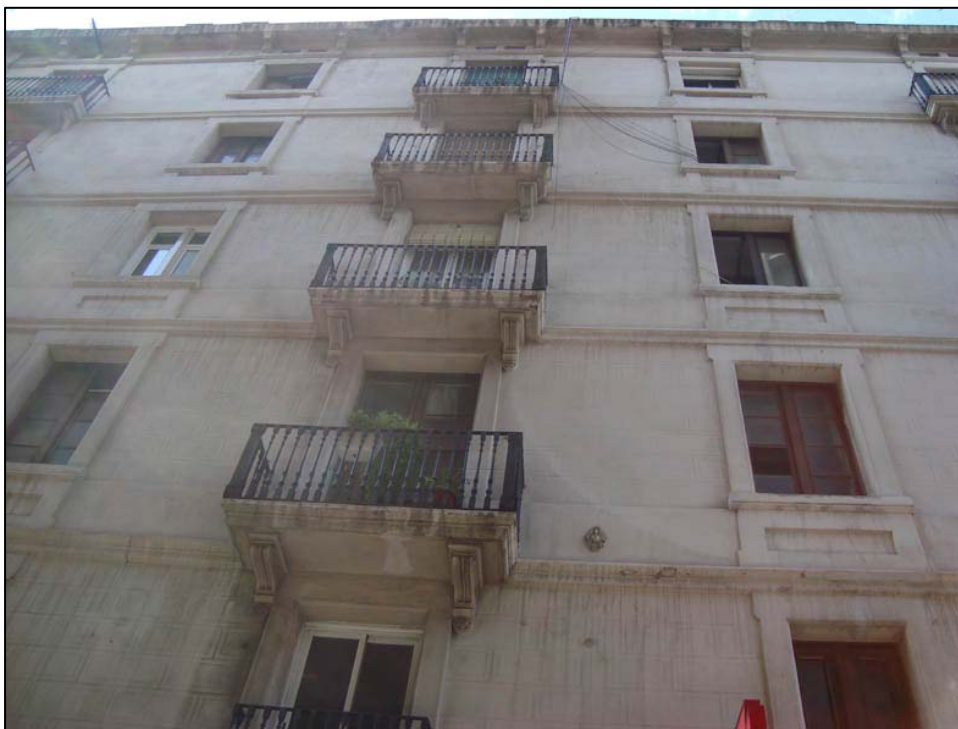
Vista de la façana de la finca
