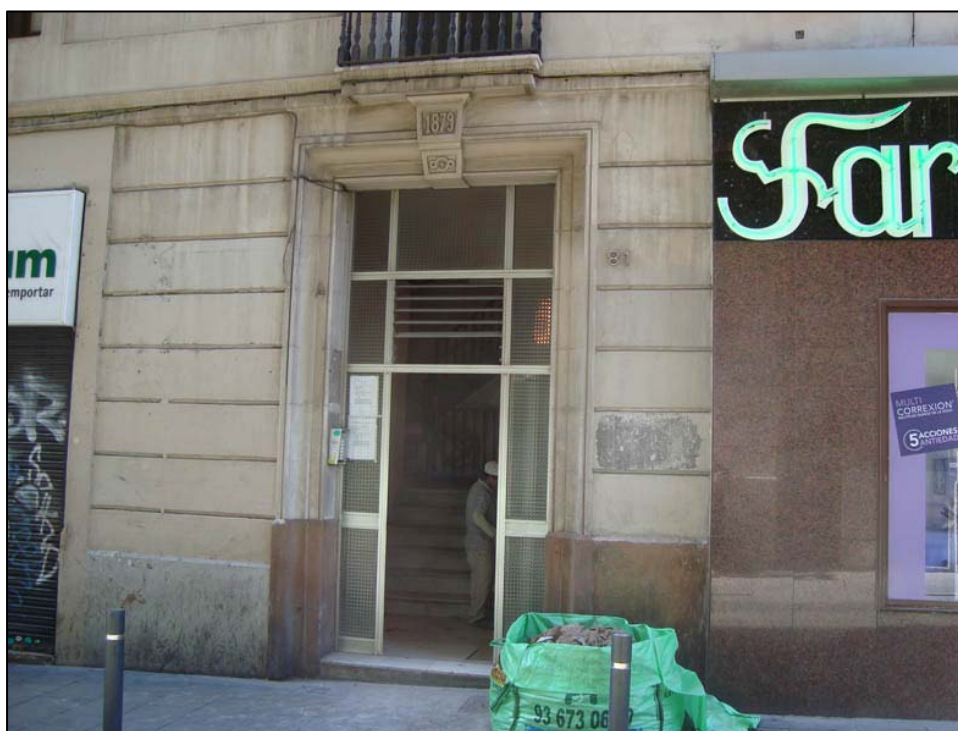
Vista del portal de la finca
